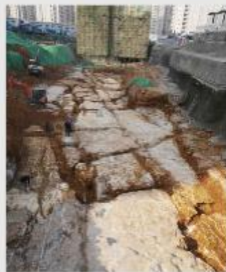
基底物探现场探测
