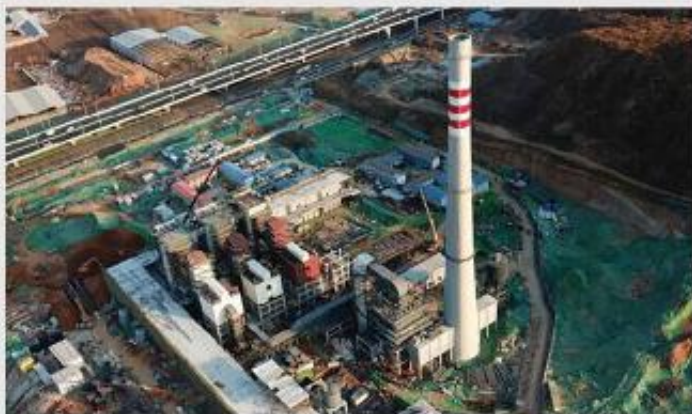
济南腊山热源厂地质灾害评估项目
