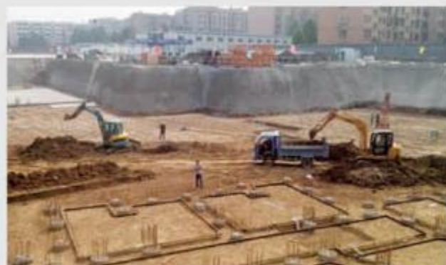
济南世茂国际广场基坑监测
