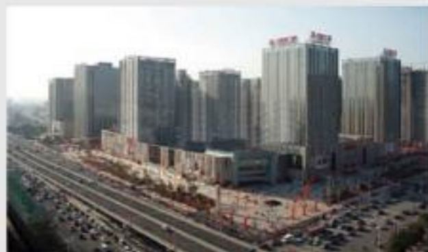
济南万达广场项目竣工测量
