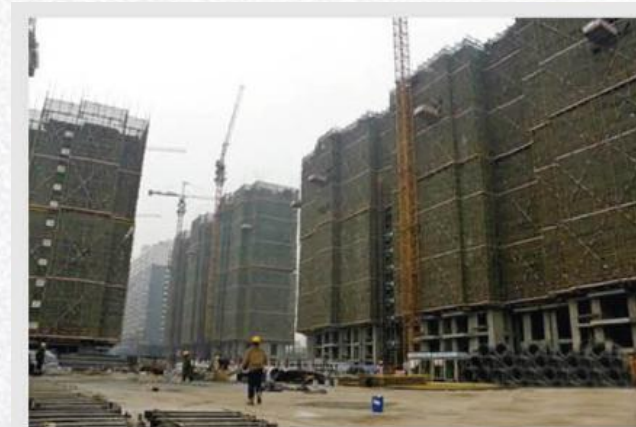
省直机关住宅项目沉降观测
